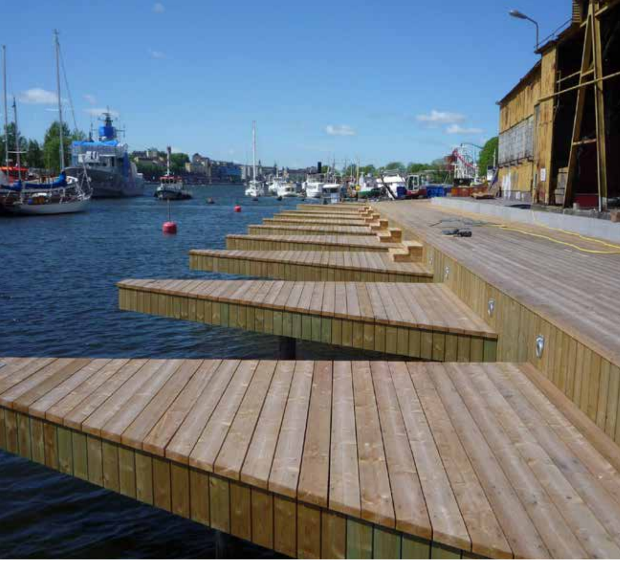
Kajen var i dåligt skick 2006
